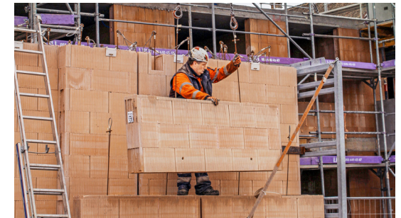
Effizientes Versetzen ganzer Backsteinelementwände
