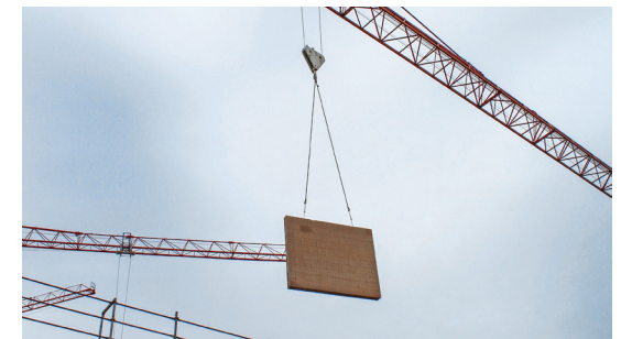
Einfach und schnelles Versetzen der Wand
